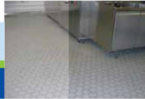
Die hohen Anforderungen hinsichtlich chemischer und mechanischer Belastung, elektrostatischer Ableitfähigkeit (ESD Anforderungen), Einhaltung der GMP Regeln und Ästhetik in diesen Bereichen stellen besondere Bedingungen an die Oberflächenschutzsysteme für die Fußböden.
