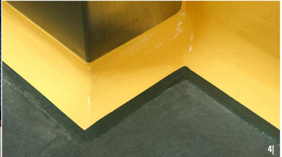
den, elastischen Dichtungsschicht unter Gussasphalt. Dazu kam das Tricoflex Abklebesystem, was sich besonders zur Abdichtung von Bauwerken im Kontakt mit Abwasser und Jauche eignet – so auch für Anwendungen in Tierställen.
