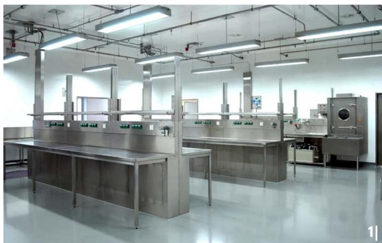
che war ein Bodenbelag erforderlich, der wasserundurchlässig, gasdicht sowie leicht zu reinigen ist. Zudem müssen die Oberflächen säure-, laugen- und lösungsmittelbeständig sein sowie die Behandlung mit Desinfektionsmitteln vertragen. All diese Eigenschaften werden in nur einer Systemlösung vereint, die entsprechend der unterschiedlichen Sicherheitsstufen in den einzelnen Gebäudeteilen zur Anwendung kam.
