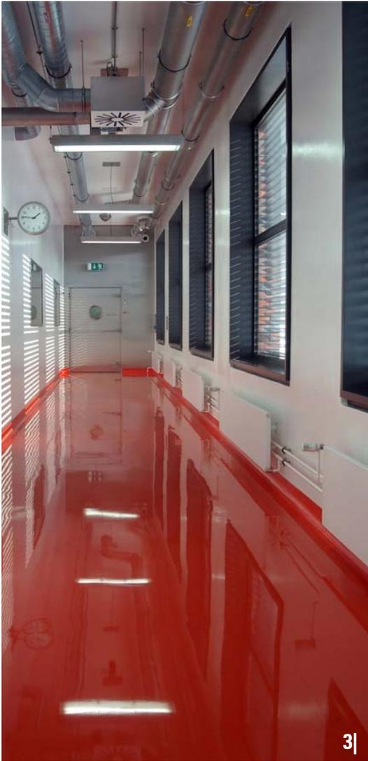
zudem dekontaminierbar. Außer in Laboren findet Sikafloor-2530 W daher auch Anwendung in Produktions- und Lagerhallen.
